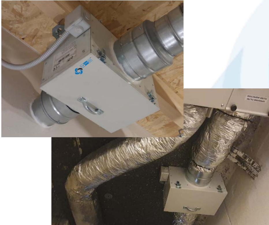
*Filtro elettrostatico basato sul processo di precipitazione elettrostatica il cui effetto è comparabile con l'attrazione degli oggetti di ferro verso un campo magnetico.*
