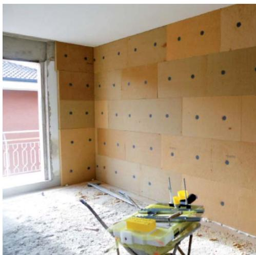
I vincoli che possono riguardare un edificio esistente determinano spesso l'impossibilità di intervenire con un isolamento esterno "a cappotto". Per tale ragione il risanamento energetico con l'isolamento termico interno diventa talvolta necessario o una soluzione alternativa valida. Questa strategia necessita però di competenze tecniche progettuali ed esecutive specifiche.
