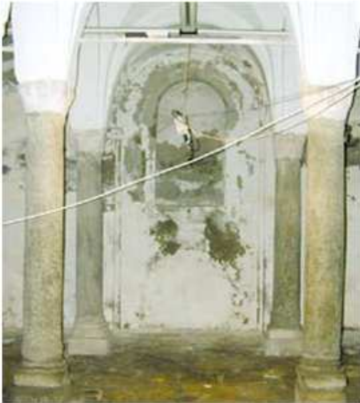
Umidità nelle murature , esempio della Cripta S. Sepolcro Milano
